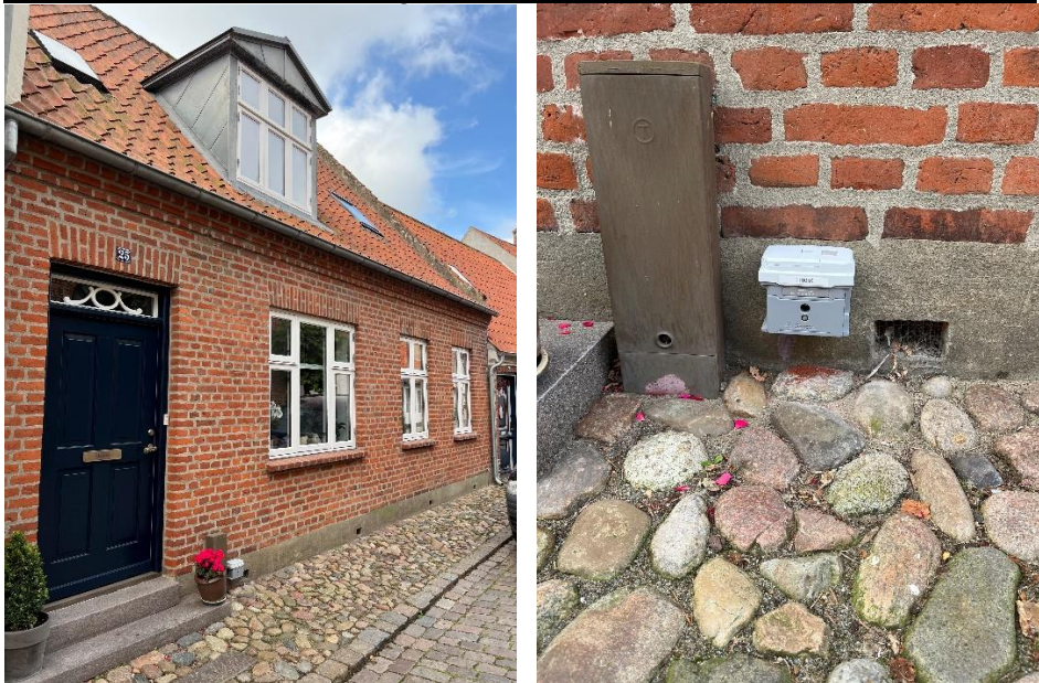
VIB 15: Sønderportsgade 25. Fredningsstatus: Bevaringsværdi 5.
